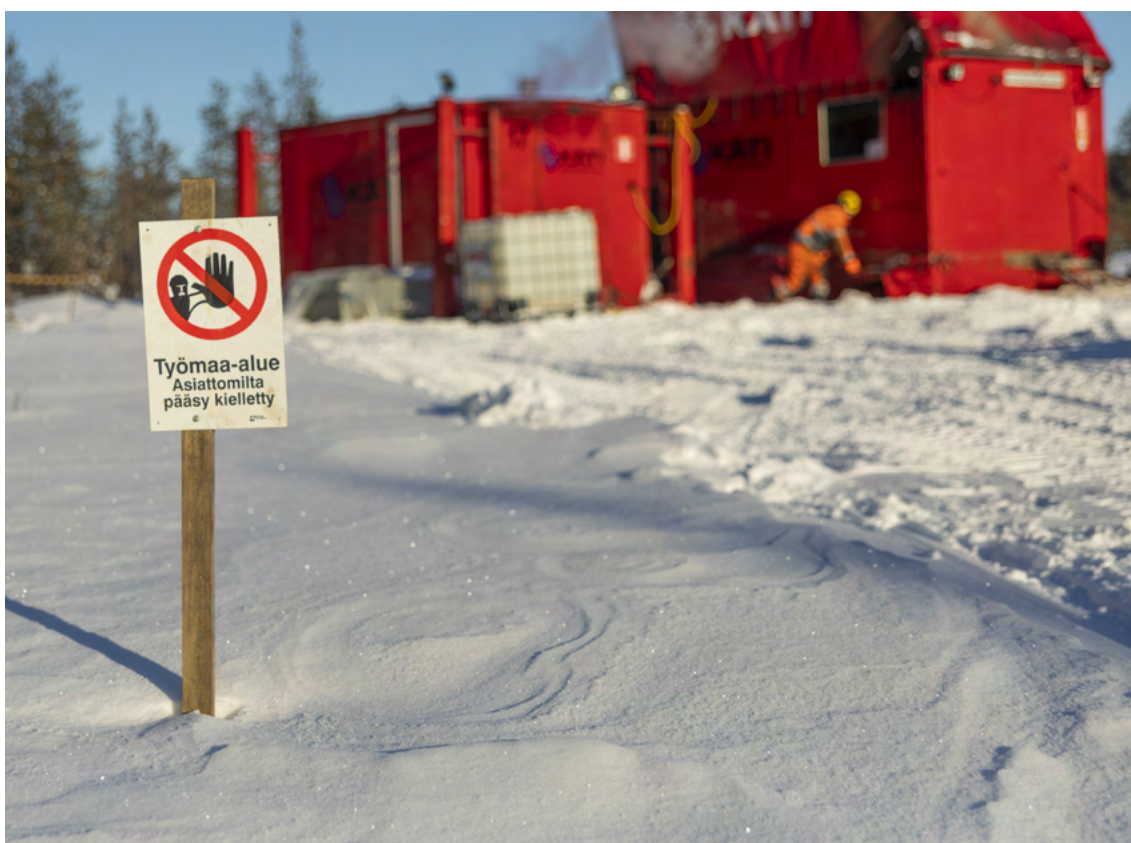
Työmaa-alue tulee merkitä selvästi varoituskyltein. Kuva: AA Sakatti Mining Oy.
