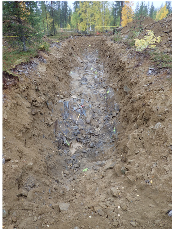
Tutkimuskaivannon muoto tulee suunnitella turvallisesti. Kuva: GeoPool Oy.
